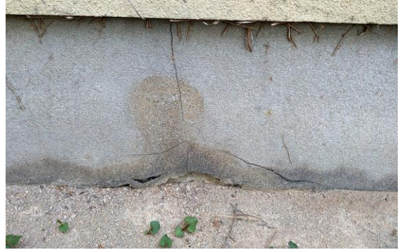
【8面】外壁及び軒裏（構造） / (1) 外壁等下地材まで到達するひび割れ、欠損、浮き、はらみ又は剥落【各仕上げ共通】
