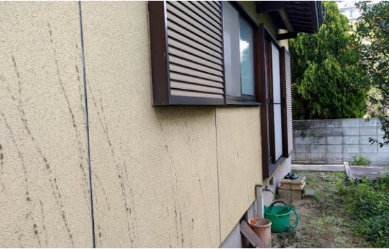
【8面】外壁及び軒裏（構造） / (3) 金属の著しい錆び又は化学的侵食
