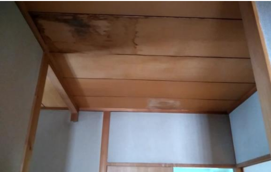
【13面】内壁（雨水） / (1) 内壁の雨漏りの跡
