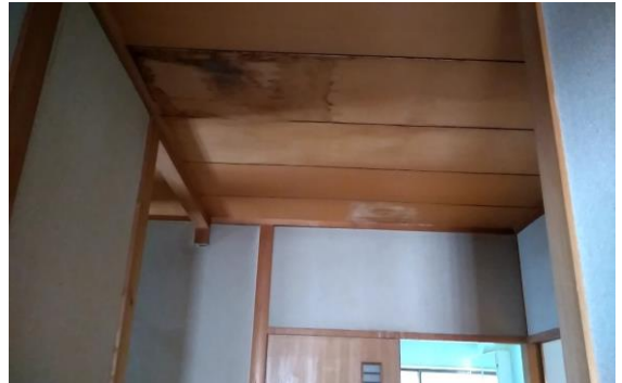
【14面】天井（雨水） / (1) 天井の雨漏りの跡
